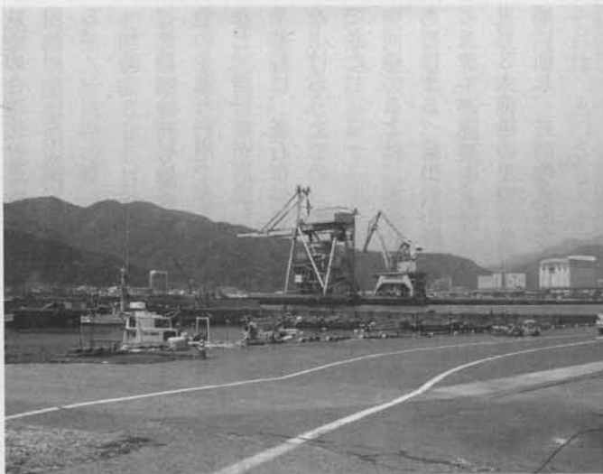
24時間365日稼働が可能な釜石港のクレーン (佐藤由紀氏撮影)
